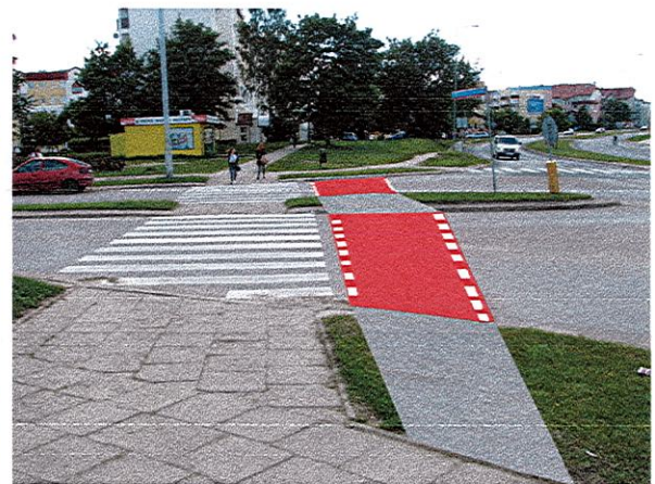
Fot. 2c.6) Wnioskowane rozwiązanie.
