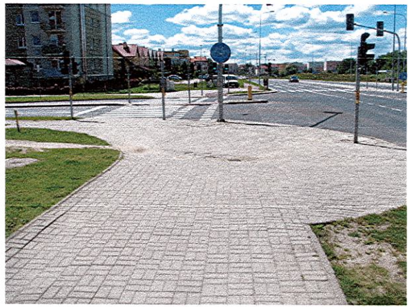
Fot. 2e.2) Stan istniejący.
