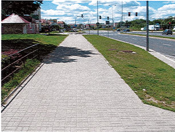
Fot. 2e.1) Stan istniejący.
